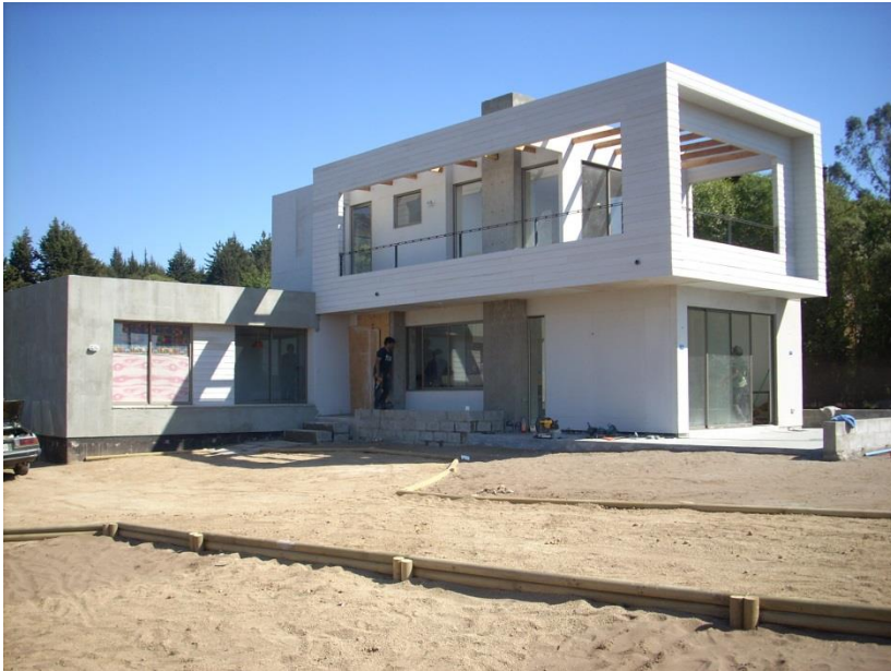
MES 5: INSTALACION DE REVESTIMIENTOS
