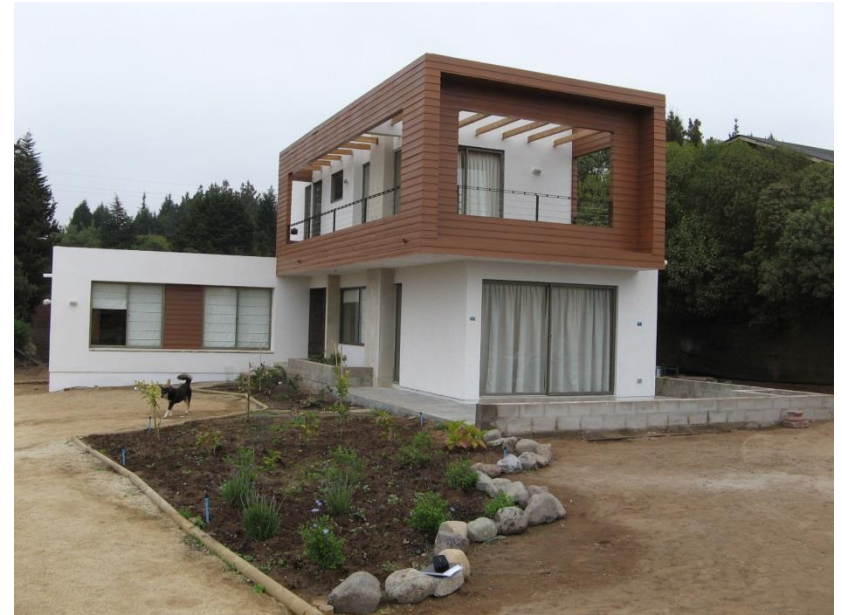
MES 6: PINTURA Y TERMINACION FINAL
