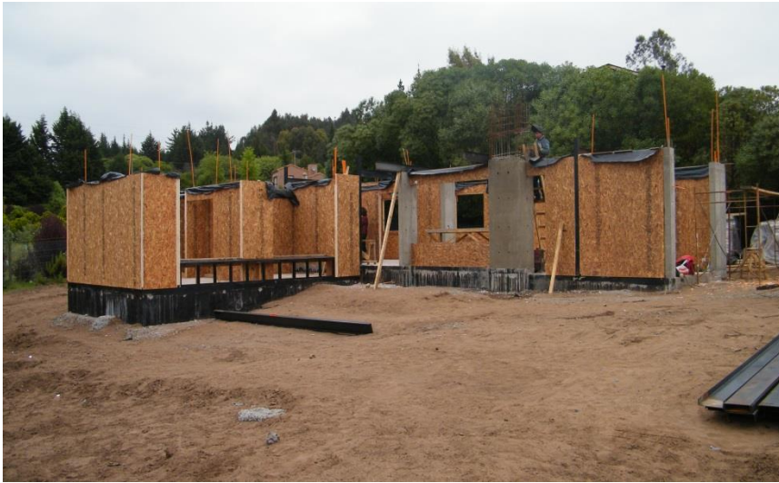
MES 3: MONTAJE DE PANELES
