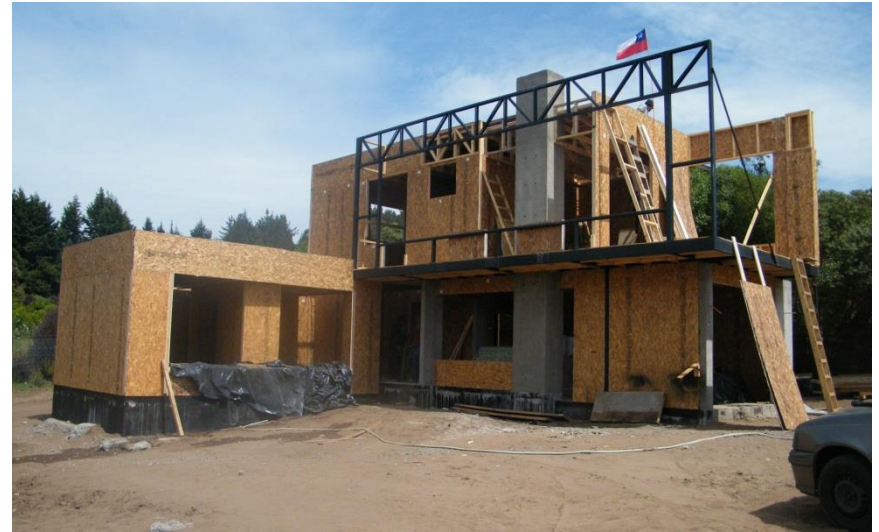
MES 4: MONTAJE ESTRUCTURAS METALICAS
