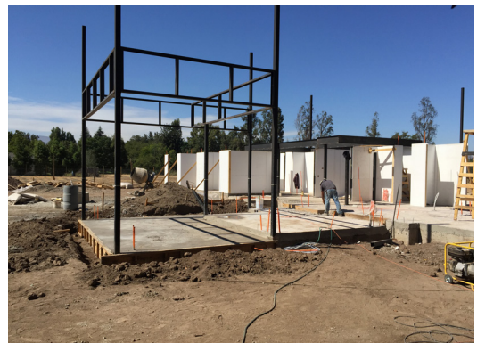
Instalación de paneles sobre soleras
