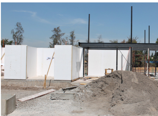
Instalación de pie derechos
