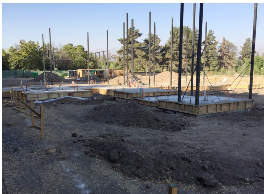
Instalación de soleras sobre radier
