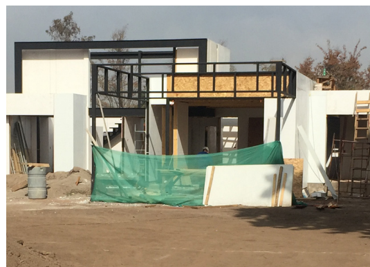
Construcción lista para pintas e instalación de ventanas
